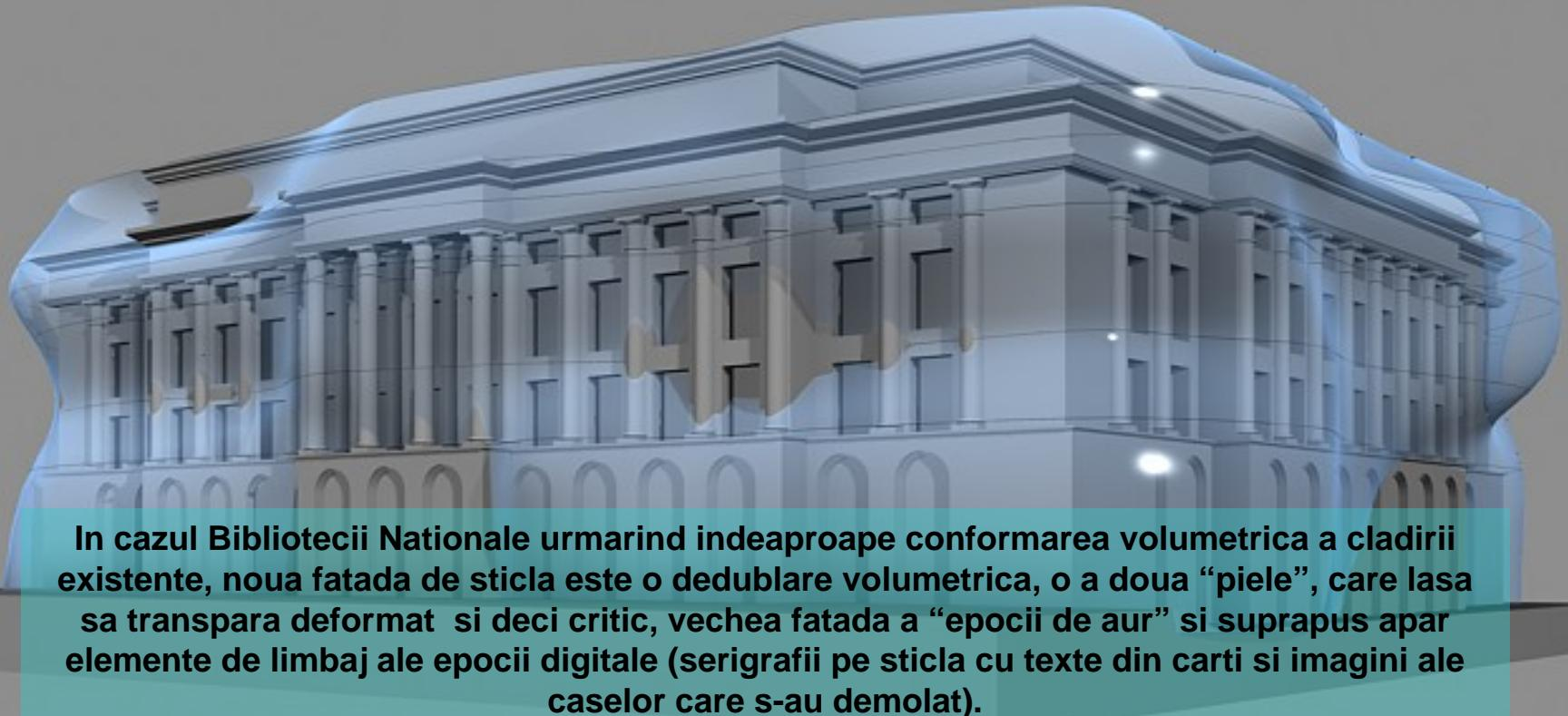
In cazul Bibliotecii Nationale urmarind indeaproape conformarea volumetrica a cladirii existente, noua fatada de sticla este o dedublare volumetrica, o a doua "piele", care lasa sa transpara deformat si deci critic, vechea fatada a "epocii de aur" si suprapus apar elemente de limbaj ale epocii digitale (serigrafii pe sticla cu texte din carti si imagini ale caselor care s-au demolat).
